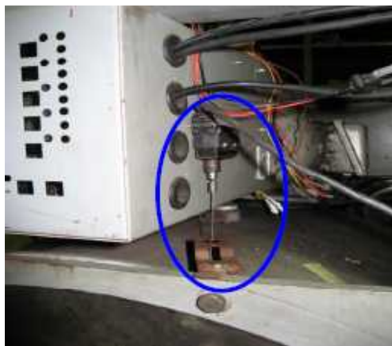
Рис. 2 Узел датчика вибрации.
